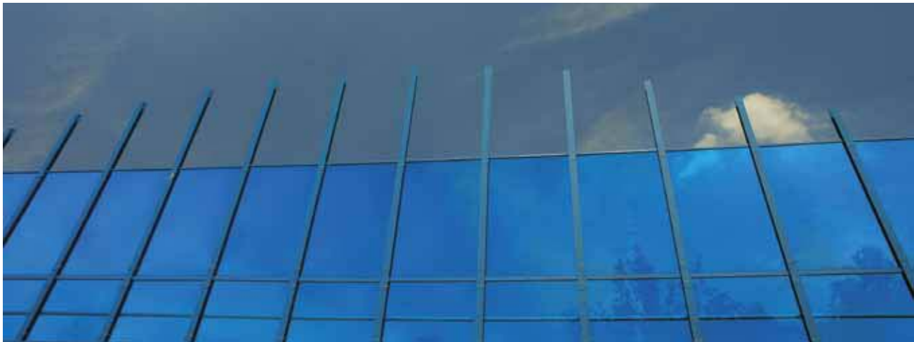
Wenn Entwicklungen am Ursprungsstandort aufgrund zu geringer Abstände nicht mehr möglich sind – Lärmschutzwand.
