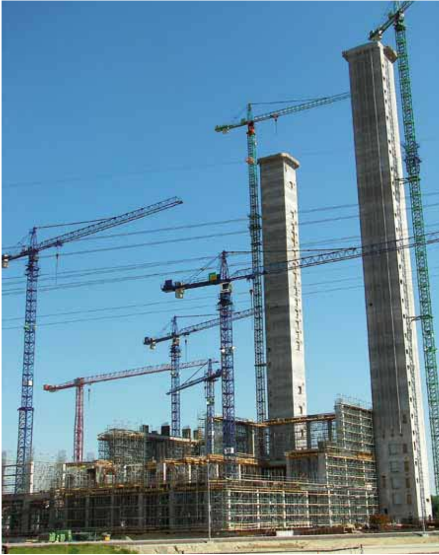
Das im Bau befindliche Kohlekraftwerk Datteln am Dortmund-Ems-Kanal, Anfang Mai 2008. Baubeginn war im November 2007. E.ON errichtet ein komplett neues Kraftwerk, Datteln 4. Die Inbetriebnahme ist für 2011 vorgesehen. Das neue Kraftwerk wird unter anderem die veralteten Kraftwerksblöcke Datteln 1 bis 3 ersetzen, die bis 2015 abgeschaltet werden sollen. Das neue Kraftwerk liegt gegenüber des alten, auf der anderen Kanalseite. Betrieben wird es mit Steinkohle. Im alten Kraftwerk Datteln werden allein 20 Prozent des Stromes für die Deutsche Bahn erzeugt. 45 Prozent aller Haushalte in Datteln beziehen vom Kraftwerk Fernwärme.
